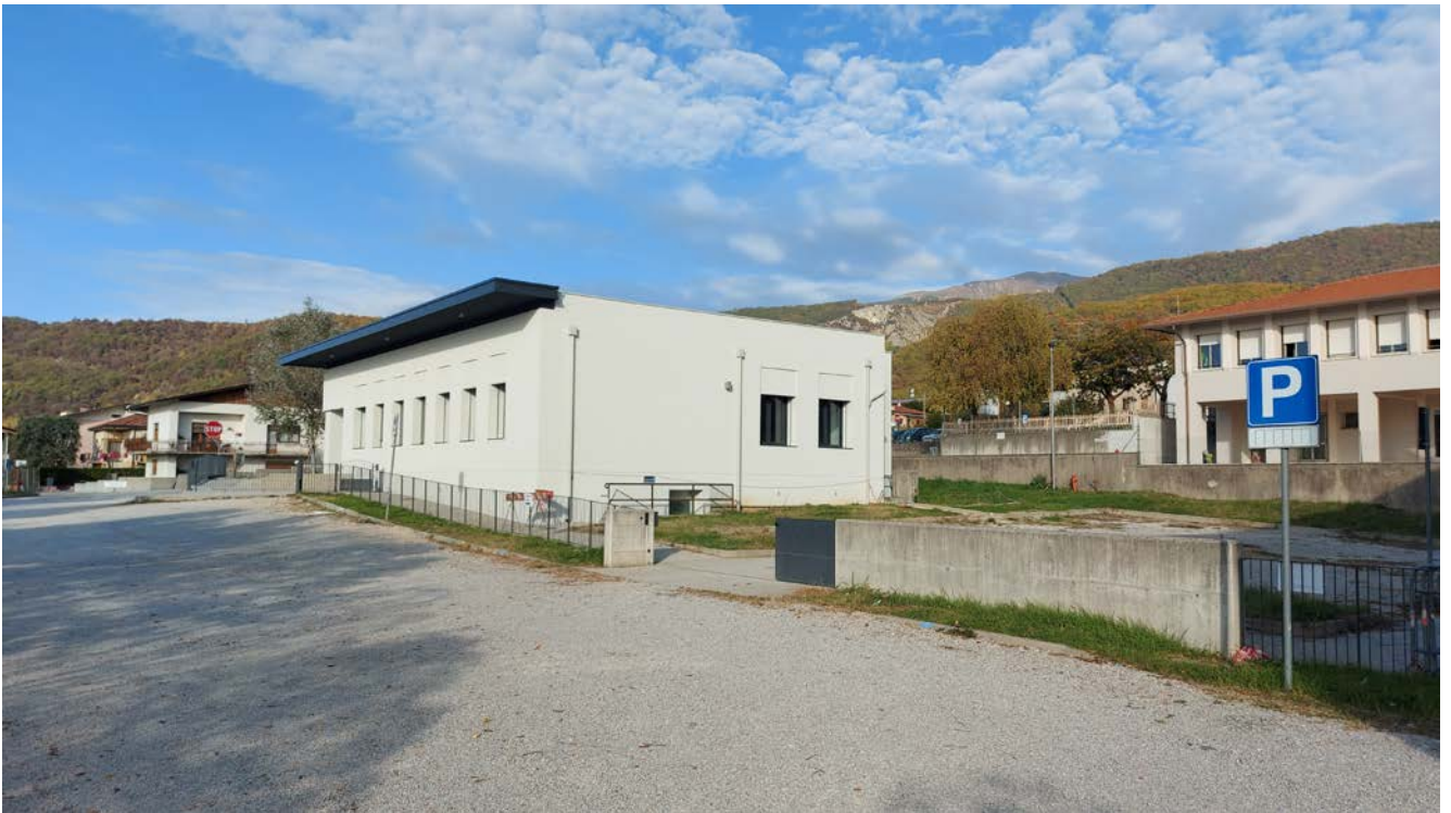
FOTO 3: prospetto sud e prospetto est.
