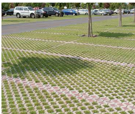
Esempio di pavimentazione drenante inerbita
