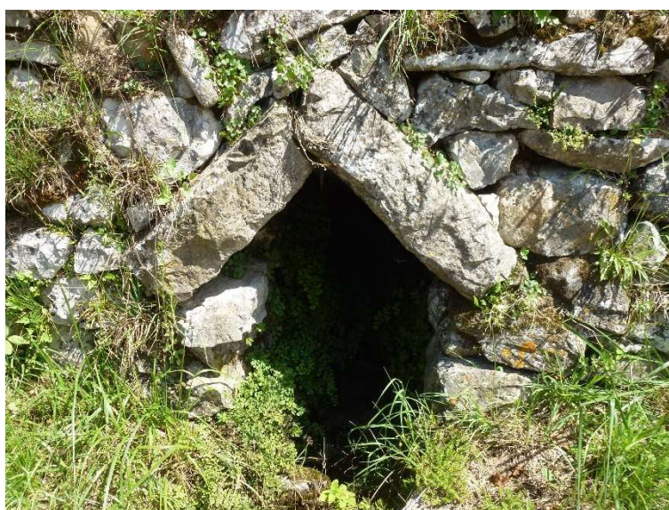
Figura 140 – Piccoli manufatti lungo i percorsi del Parco
