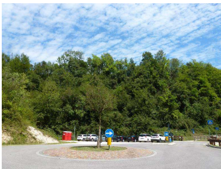
Figura 76 – Nuova rotonda e parcheggio all'interno del Parco, al servizio della fruizione turistica
