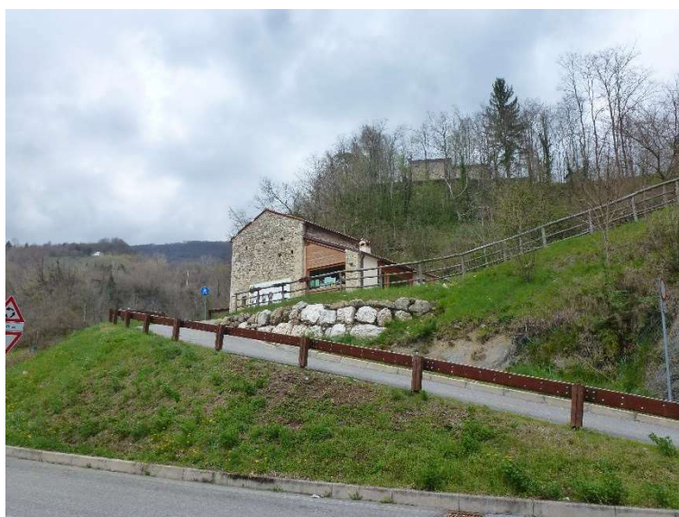
Figura 117 – Zona di penetrazione n. 2; centro visite
