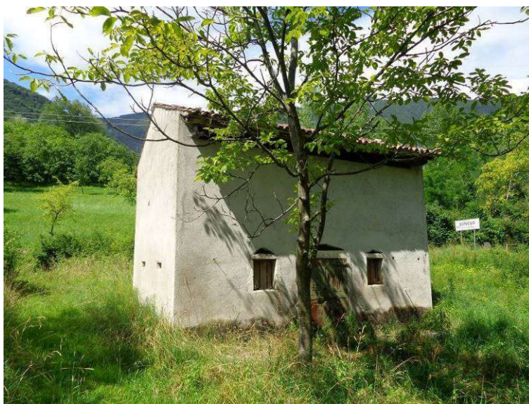
Figura 105 - Gate 3 - Sonogo: edificio esistente da adibire a centro visite
