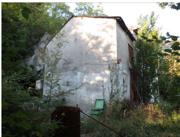
Figura 130 – Foto del fabbricato da adibire a Centro Visite
