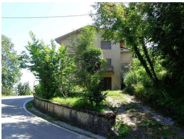
Figura 108 - Gate 6 - Breda: edificio da adibire a centro visite
