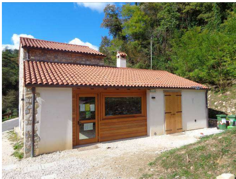
Figura 134 – Foto del Centro Visite di Via Ronzon
